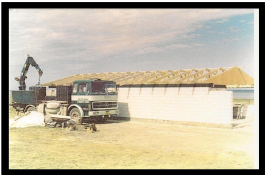
Mercedes 1418 - HIAB 174 med nok montering
